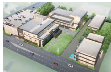
和光市広沢複合施設整備・運営事業 (2022年1月竣工予定)
