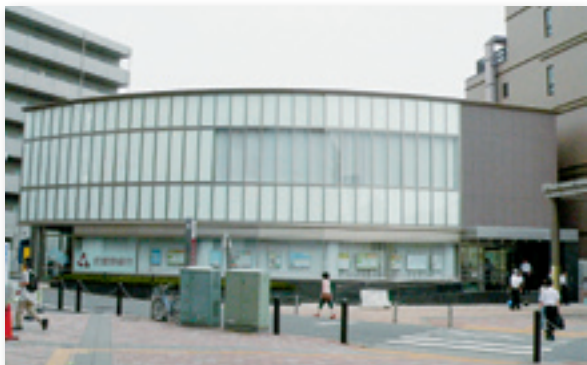
新座支店外観
