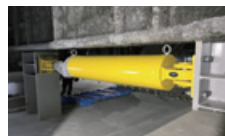
オイルダンパー 地震時の揺れおよび建物の変形を小さく抑えます。
