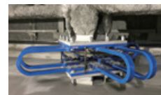
U字ダンパー 風揺れや地震時の揺れおよび建物の変形を小さく抑えます。
