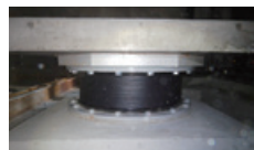
積層ゴム 地震エネルギーを吸収し、建物の損傷を大きく低減します。
