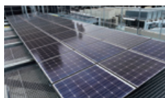
屋上に太陽光パネルを設置
