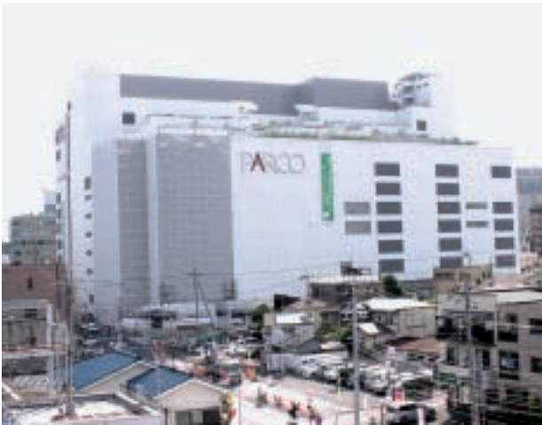
〔浦和駅東口に建築中の商業施設〕
