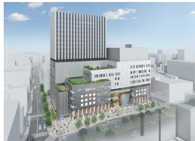
大宮駅東口大門町2丁目中地区市街地再開発事業 (提供：再開発組合)
