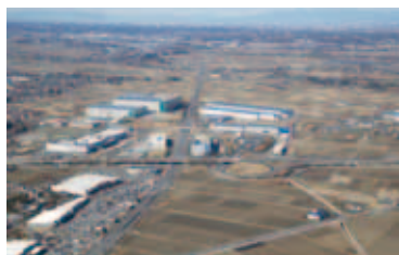
圏央道川島IC周辺 ©国土交通省関東地方整備局大宮国道事務所
