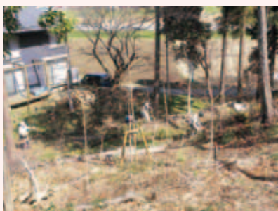
▶枯れ木の伐採作業
