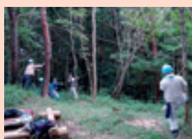
▲アカマツの伐採作業。
