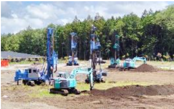
某工場 スリーエスG 工法
