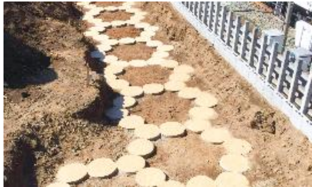
鉄道振動抑制工事 WIB 工法
