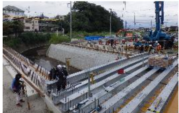
橋梁架換工事
