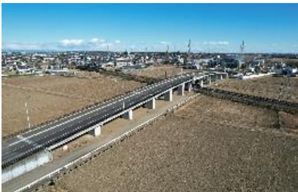
5-79 号橋(毛塚)補修・耐震補強工事
